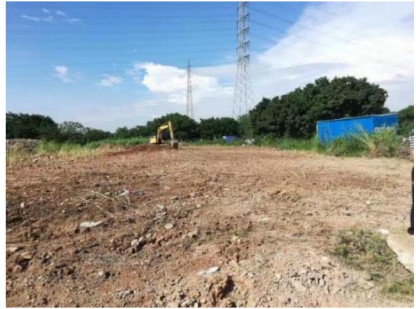
施工期现场照片 5（箱涵施工后覆土）
