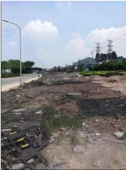
施工现场照片 2 (开挖施工前)
