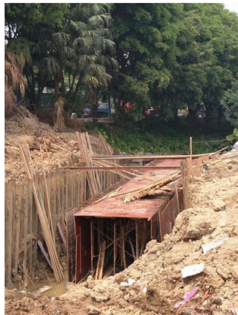
施工期现场照片 3 (新箱涵施工)
