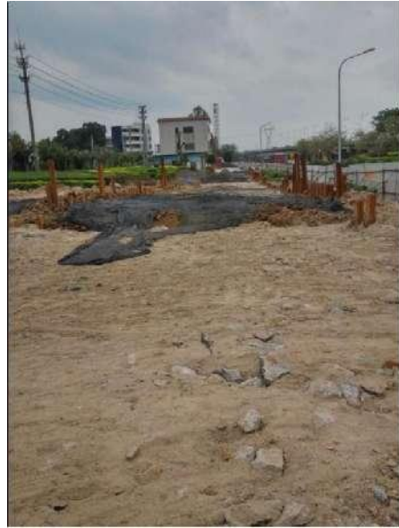
施工现场照片 1 (开挖施工前)
