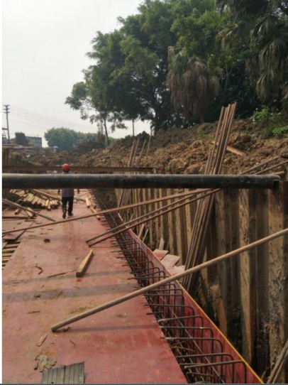
施工期现场照片 4（新箱涵施工）
