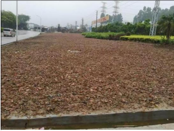
施工期现场照片 6（覆土后）
