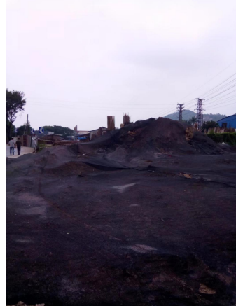
施工期现场照片 7（临时堆土场）
