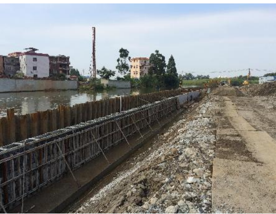
施工现场照片 2（围堰填筑）
