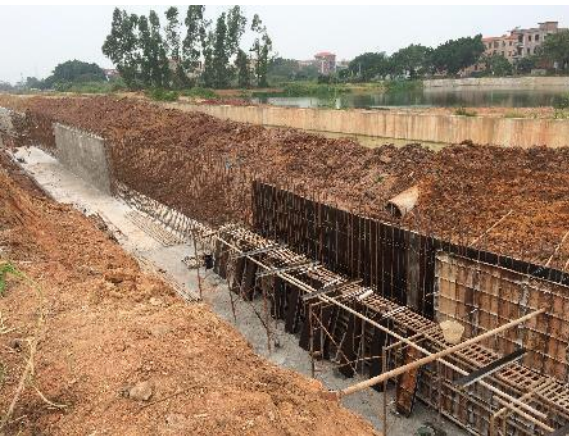
施工期现场照片 4（桩基础及地基处理）
