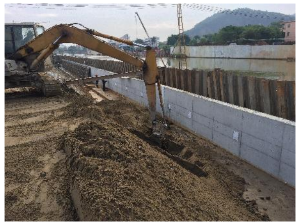
施工期现场照片 3（基坑开挖）
