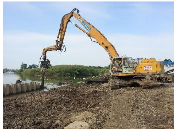
施工期现场照片 5（护岸护坡）
