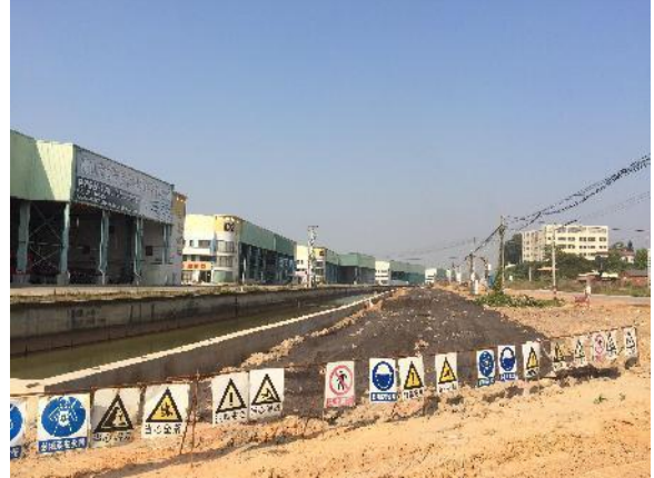
施工现场照片 1（开挖施工前）
