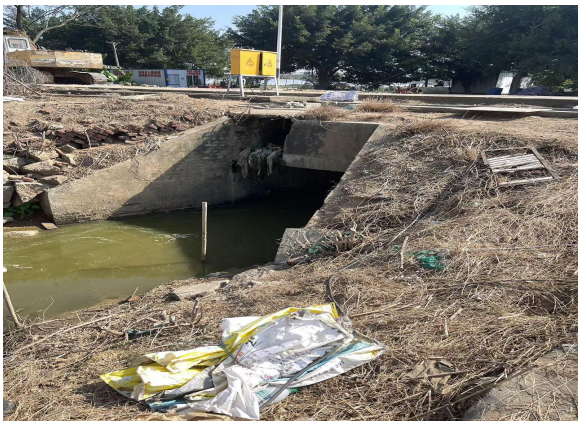
项目建成后 2#桥涵
