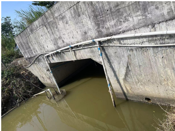
项目建成后 3#桥涵
