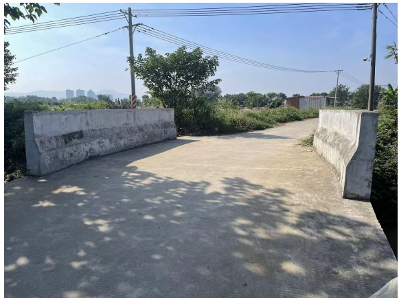
项目建成后 1#桥涵
