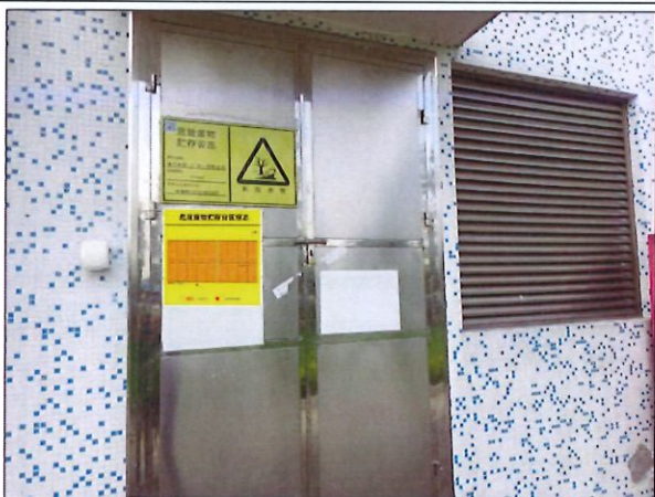
图 5-3 危险废物暂存间
