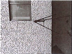
N3-项目南面厂界外1米
