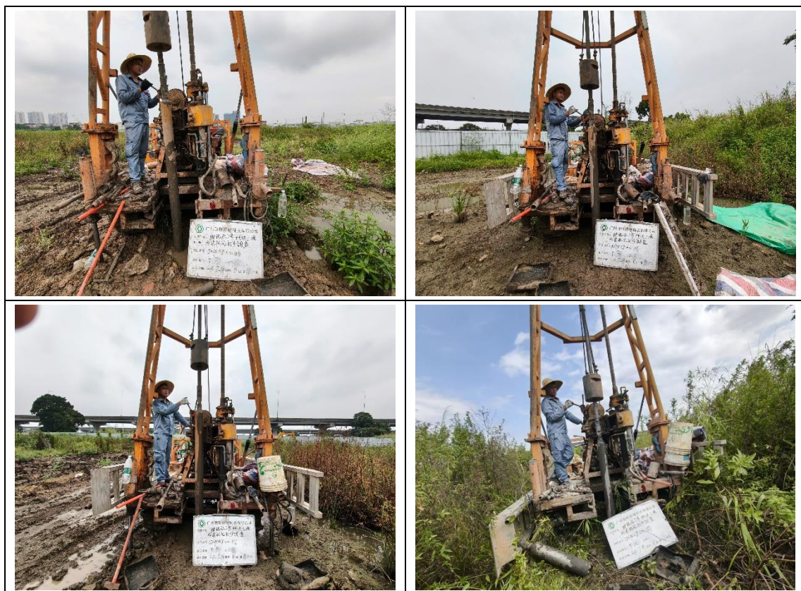
图 4.4-1 现场钻探设备及工作场景照片
