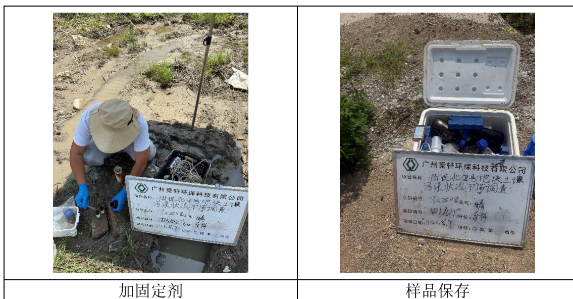
图 4.4-3 现场地下水采样照片
