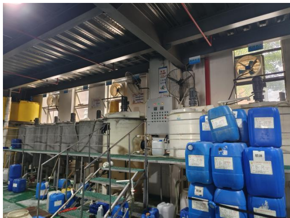
图 3-4a 首层搅拌生产区
