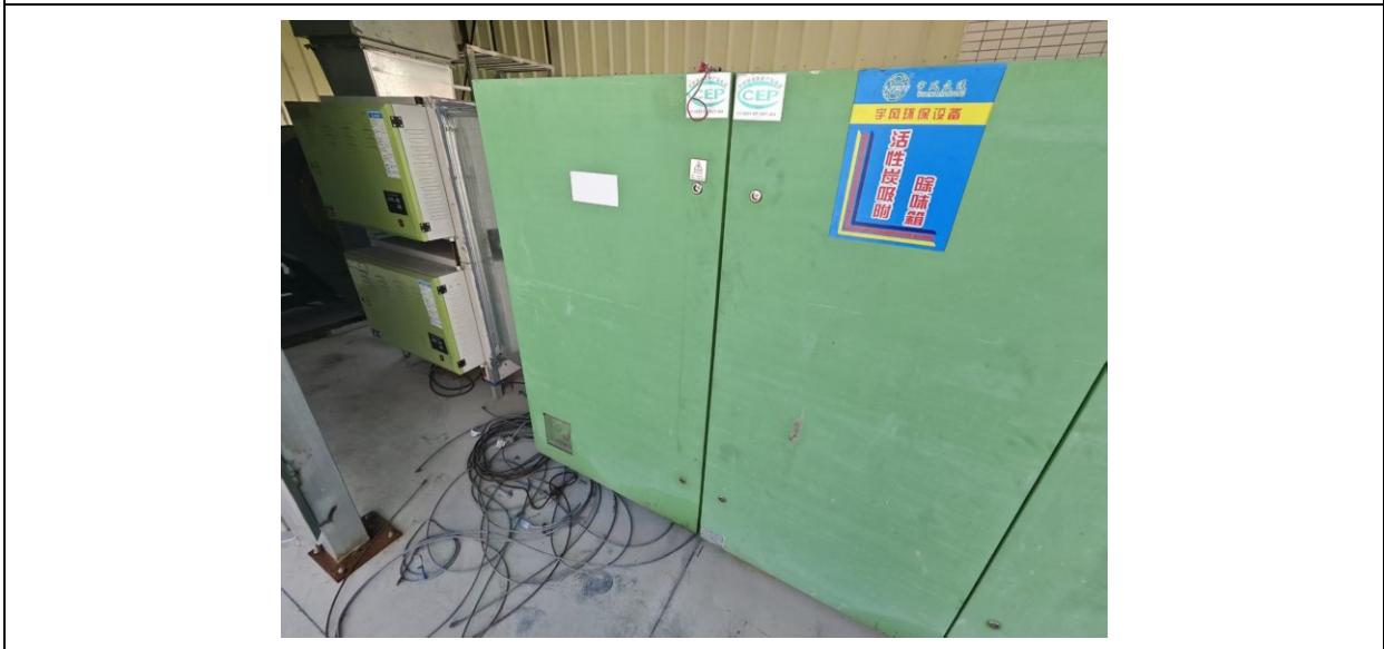
图 5-3 活性炭吸附+静电油烟净化器
