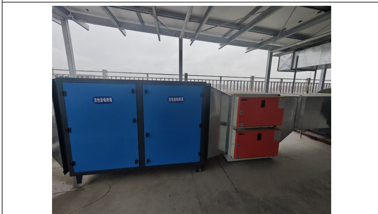
图 5-3 活性炭吸附+静电油烟净化器
